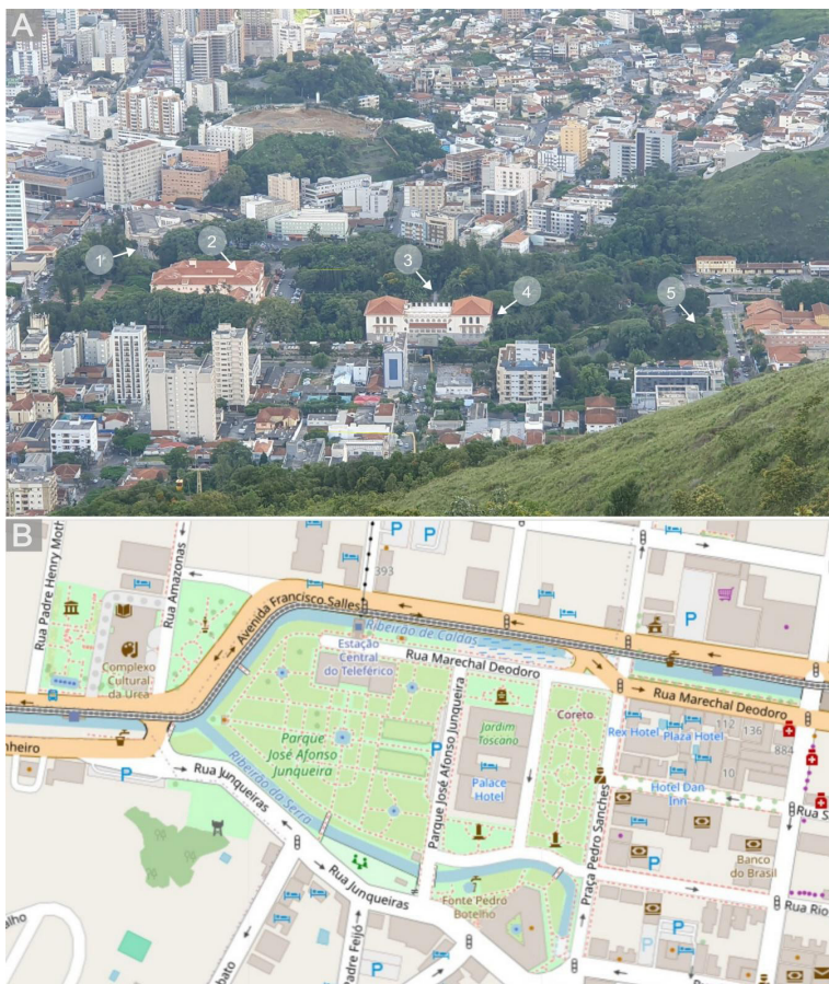
Figura 5. Organização geográfica do conjunto dos monumentos tombados estudados. A. Visão panorâmica do Parque José Afonso Junqueira que contém o Complexo Hidrotermal e Hoteleiro e a Praça Getúlio Vargas; (1) Thermas Antônio Carlos (2) Palace Hotel (3) Fonte Luminosa (4) Palace Casino (5) Praça Getúlio Vargas . B. Mapa urbano com a indicação do setor dos monumentos estudados (Fonte: https://www.cidade-brasil.com.br/mapa-pocos-de-caldas.html ); B está posicionado 180° em relação a A
